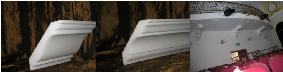
Fasety, listwy ze styroduru, podpory balkonu - sala teatralna (Piotrków Trybunalski)
